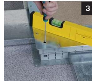
При помощи регулировочных винтов
